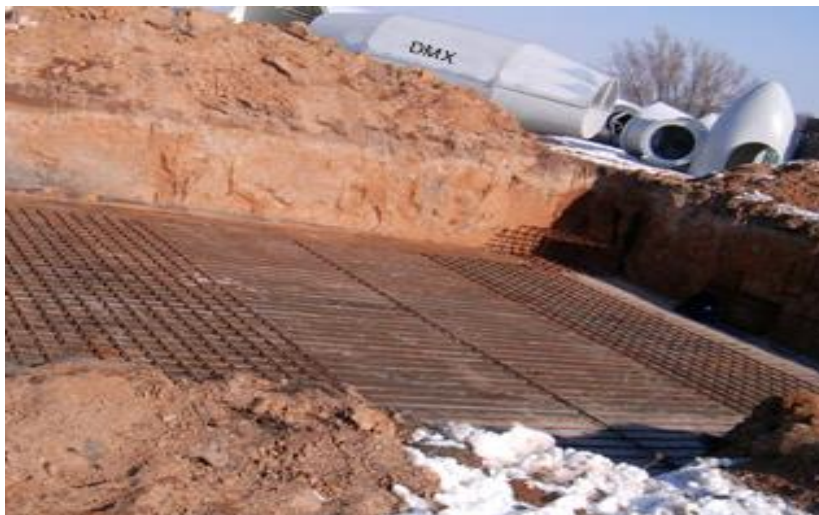
Rys. 2 Budowa fundamentu przykładowej elektrowni wiatrowej
