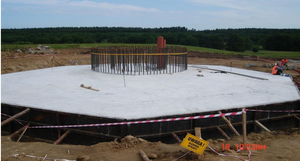
Zdjęcie 1 Budowa fundamentu (przykład nie dotyczy realizowanej instalacji).
