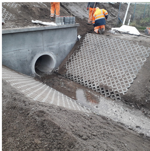
Modernizacja przepustu w miejscowości Anusin – droga G129320P
