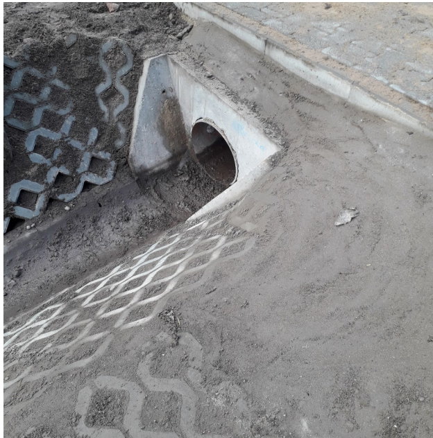
Modernizacja rowu i dwóch przepustów w miejscowości Polanowo – droga G129320P
