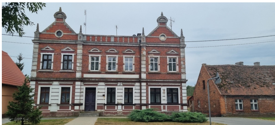
Zdjęcie nr 6 – Centrum miejscowości – charakterystyczne zbudowania z czerwonej cegły
