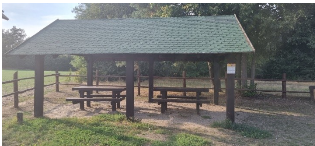
Zdjęcie nr 10 Wiata przy wejściu na Dębową Górę
